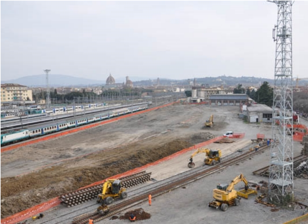
Il cantiere TAV Belfiore a Firenze
